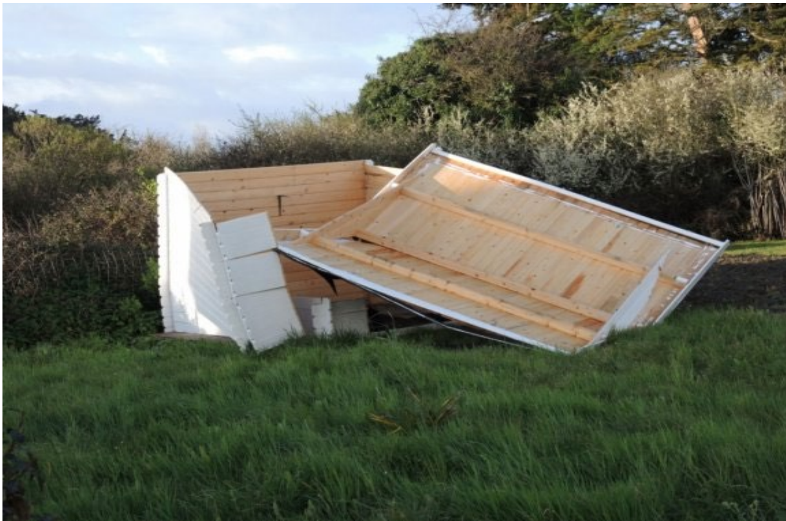
Toiture arrachée par des rafales de vent de plus de 120 km/h Quiberon, Bretagne (France)
